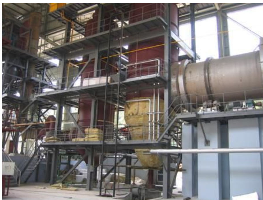
湖州市工业和医疗废物处置中心车间
