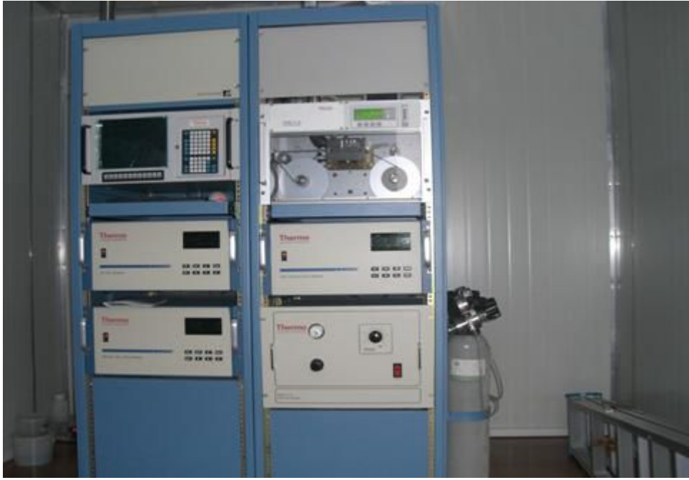
长兴县环境空气质量自动监测站内景
