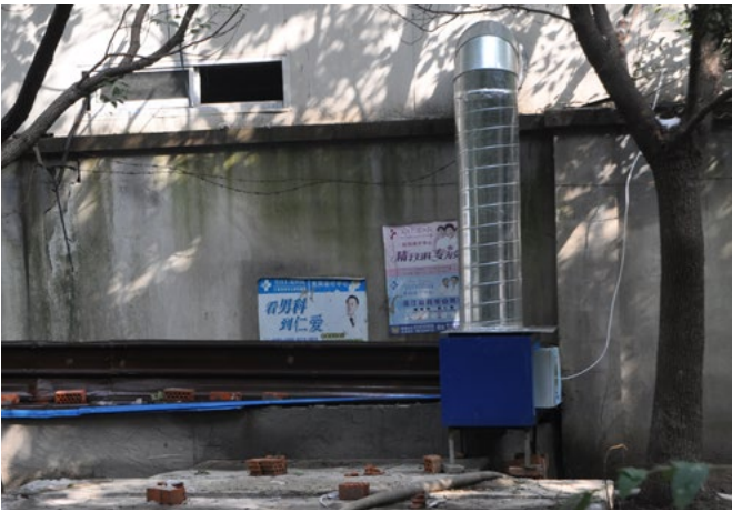
治理后 食堂安装了除油烟设备
