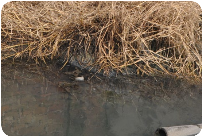
第二处排污口正在治理中
