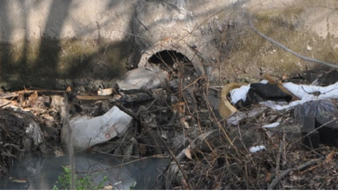
治理后 排放口已被封堵
