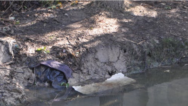
治理后 排放口已被封堵
